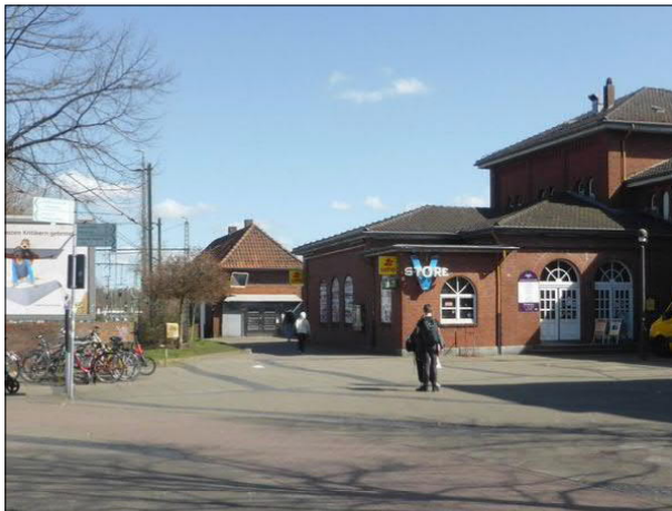
Abbildung 46: Der direkte Bahnsteigzugang nördlich des ehemaligen Empfangsgebäudes in Bremen-Vegesack ist nicht gekennzeichnet.
