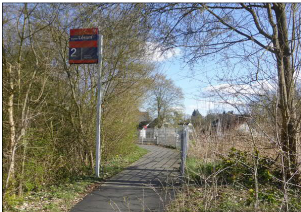
Abbildung 51: In Bremen-Lesum wurde die Zuwegung am westlichen Zugang zu Gleis 2 in der Höhe an den Bahnsteigzugang angepasst und asphaltiert. Eine Stufe am Übergang gehört damit der Vergangenheit an.
