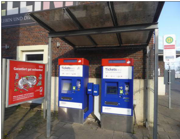
Abbildung 26: Die Vitrine im Zugang des Bahnhofs Bremen-Oslebshausen wurde vor rund drei Jahren mit dem Aufbau des zweiten Fahrkartenautomaten versetzt und ungünstig mit der Rückseite zum Zugang ausgerichtet.
