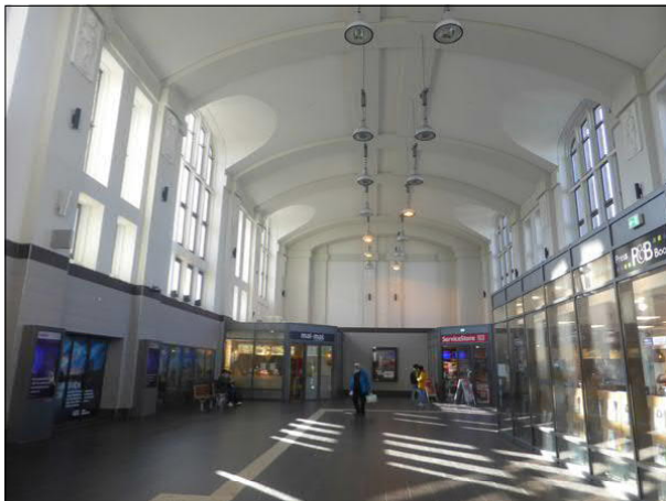
Abbildung 29: Einzelne Strahler in der Eingangshalle von Bremerhaven Hbf waren tagsüber eingeschaltet.
