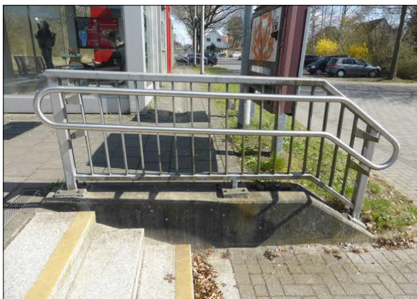
Abbildung 6: An Gleis 1 in Bremen-Schönebeck sind einige Handläufe nicht passend zur jeweiligen Treppe, sondern passend zum Gelände installiert worden. Das sieht gut aus, ist aber für die Fahrgäste weniger hilfreich.
