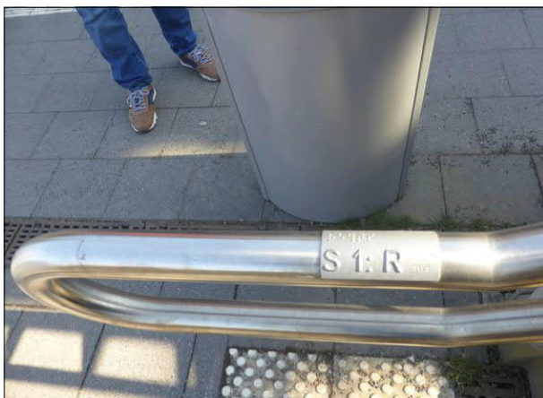
Abbildung 24: Die taktilen Wegeleitungsschilde halten auf vielen Handläufen der Bahnsteigtreppen nicht dauerhaft. Auch in Bremerhaven-Wulsdorf fehlt ein Teil der Beschilderung für Sehbehinderte.
