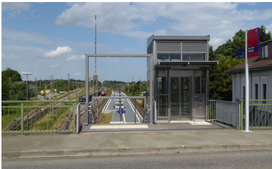
Abb. A-7: Der Bahnhof Bremerhaven-Wulsdorf wurde in den Jahren 2020 und 2021 erneuert. Durch die Aufhöhung des Bahnsteigs und den Einbau eines Aufzugs wurde die barrierefreie Erreichbarkeit der Züge hergestellt. (Quelle: ZVBN)
